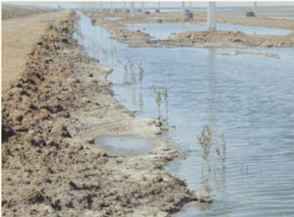
قناة تصريف المياه إلى البحر
